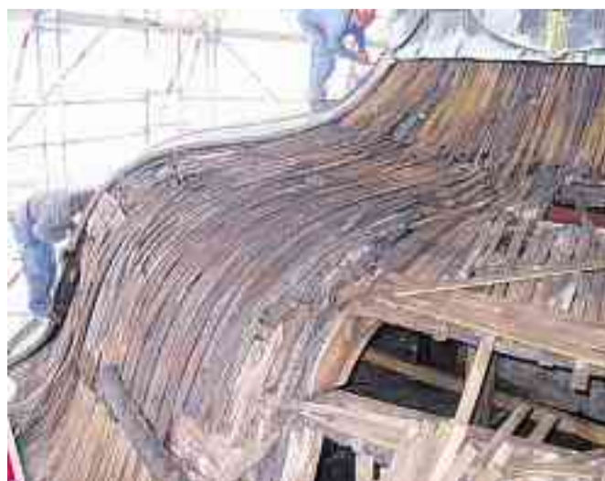
Eines ihrer Werke: Auch bei der Renovierung des Müller'schen Volksbads legte die Spenglerei mit Hand an.
