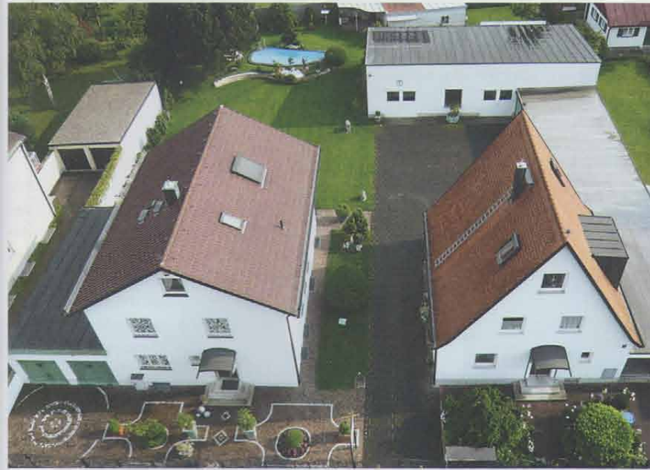
Blick auf das Bürogebäude, das Wohnhaus und die Spenglerwerkstatt der Blambergers
